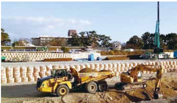
武庫川河川敷工事
